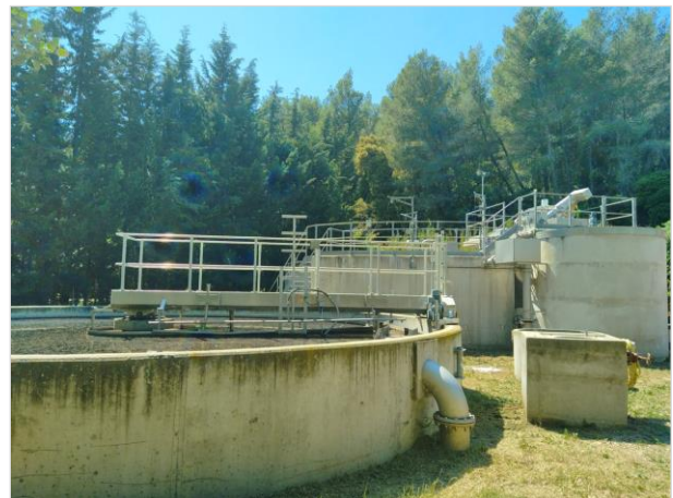
La station d'épuration à Orgon
