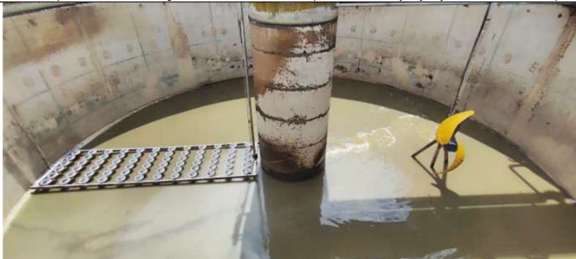
Juin 2024 : désensablage du bassin d'aération avec renouvellement des diffuseurs d'air
