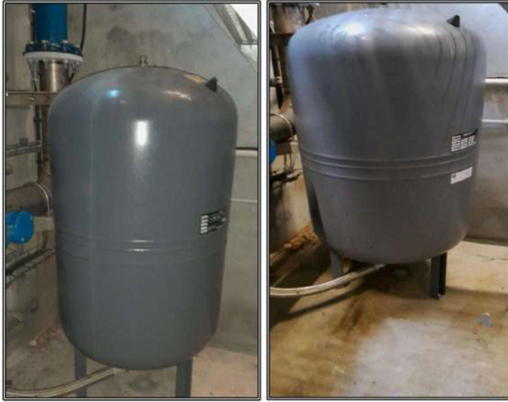
Renouvellement ballon réservoir de la Montagnette Barbentane – Octobre 2024
