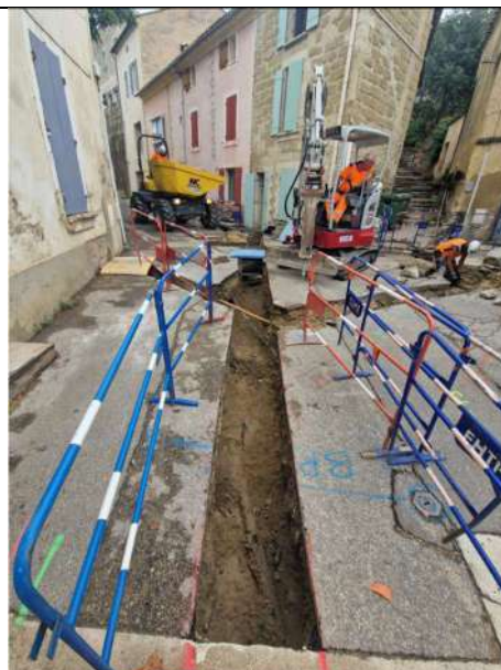
Septembre 2024 : travaux chemin sous l'Hôpital
